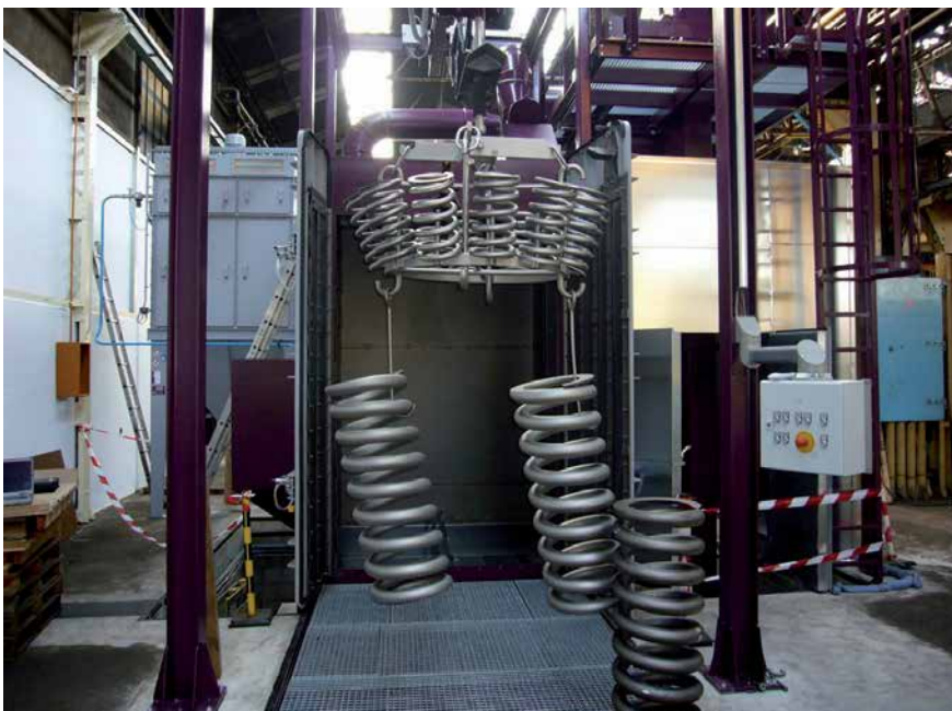
Hängebahn-Strahlanlage mit Fundament und Strahlmittelrückführung zur Bearbeitung von Federn
