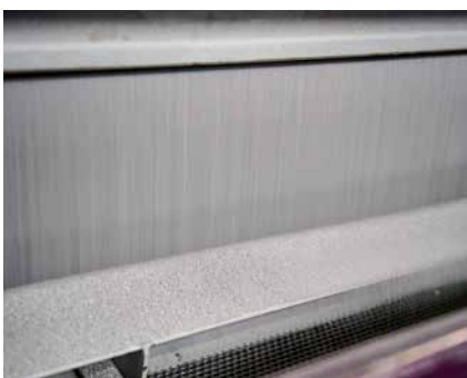
Das Strahlmittel wird gereinigt und im optimalen Betriebsgemisch im Umlauf gehalten.
