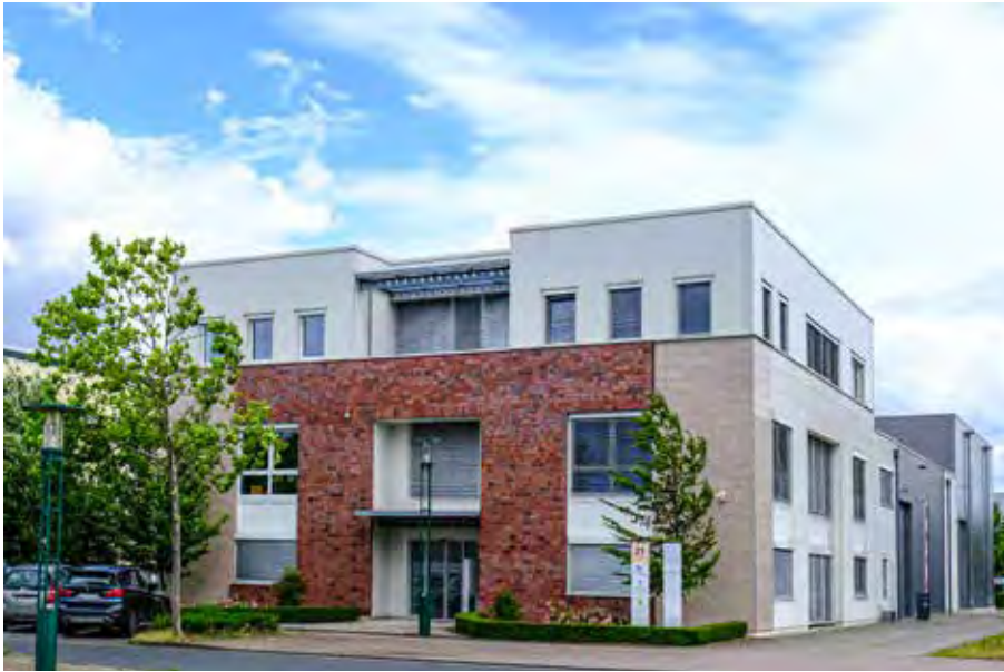
Firmensitz im Stahlwerk Becker in Willich
