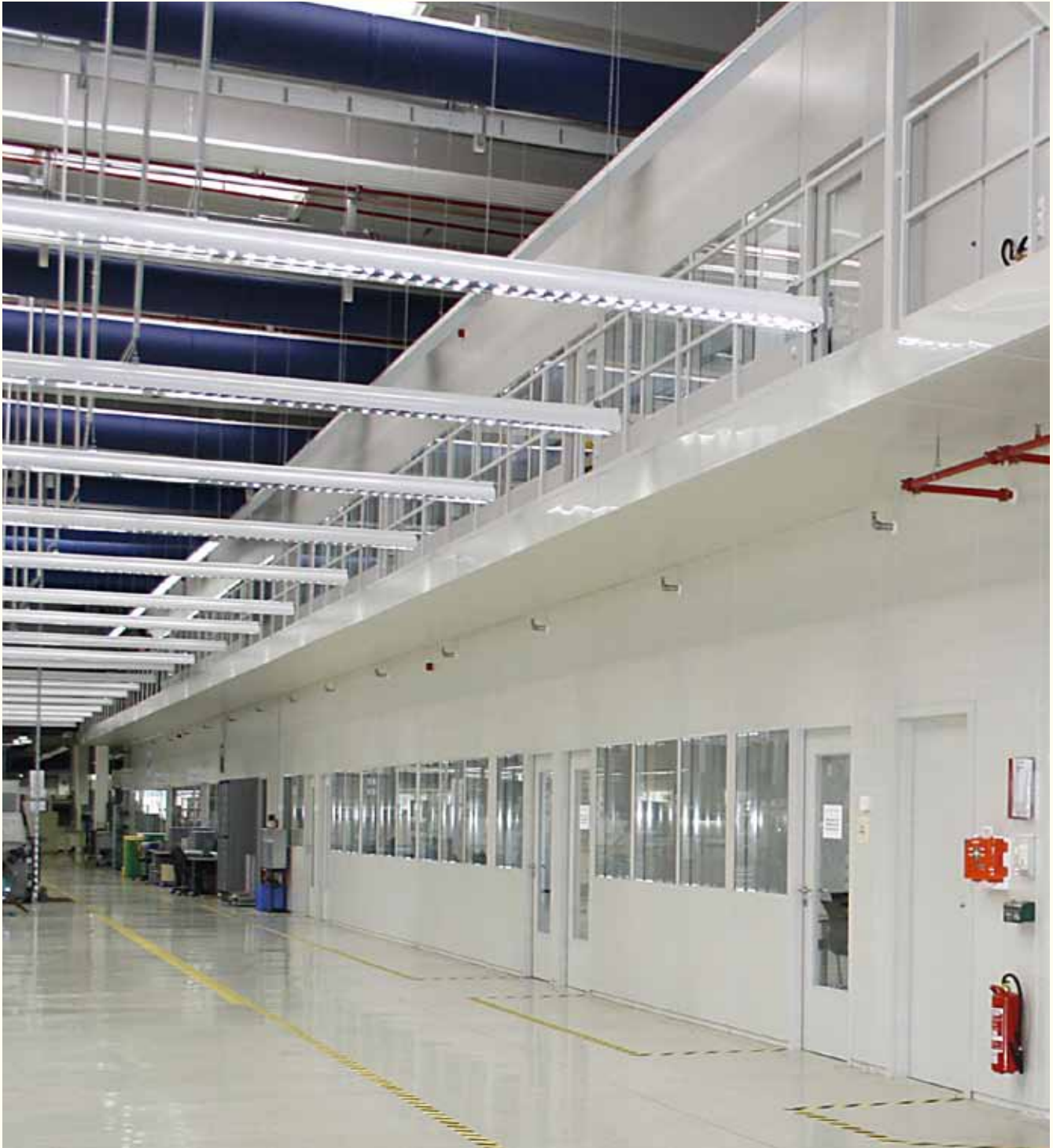
Zweigeschossige Betriebsbüroanlage mit auskragendem Laufgang
