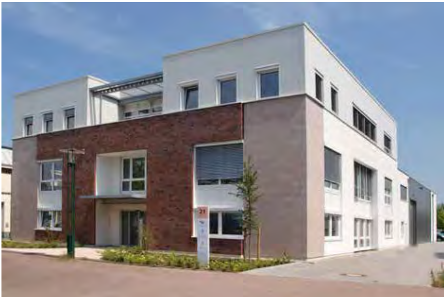
Firmensitz im Stahlwerk Becker in Willich
