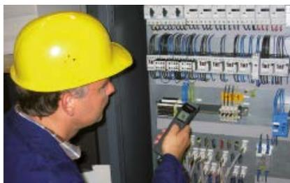
Infrarotthermometer sind bewährte zeitsparende Instrumente bei der vorbeugenden Instandhaltung von elektrischen Systemen, Kontaktstellen, elektrischen Sicherungen und Motoren, Motorspulen, Kabeln und Schaltschränken bevor Schäden auftreten.
