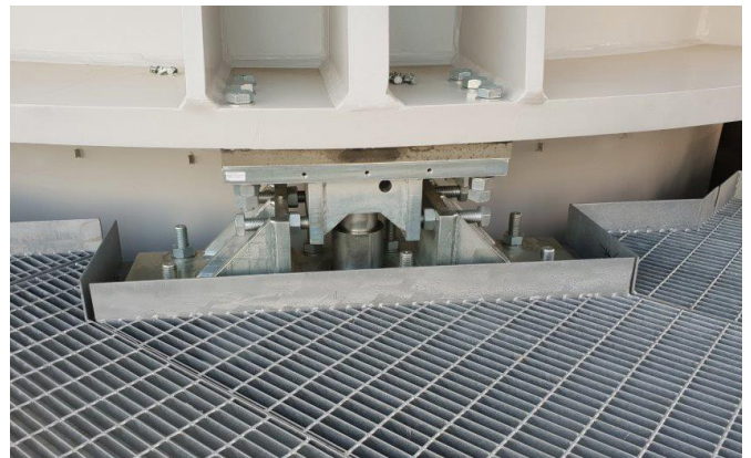
Die Wägezellen der Reihe PR 6201 können Lasten von bis zu 12 t genau verwiegen.
