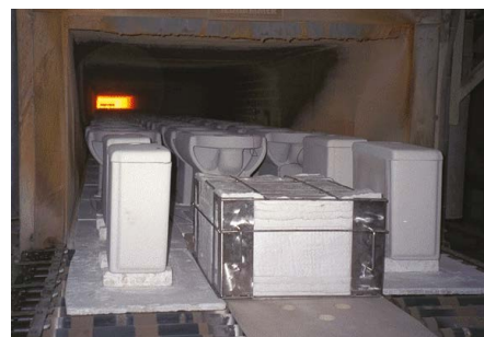
Kiln Tracker System im Rollenofen für Sanitärkeramik
