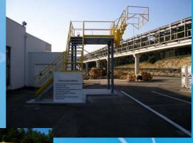
Dieses System besteht aus einem Sicherheitsaufstieg, einer festen Arbeitsbühne und einem Klappsteg.
