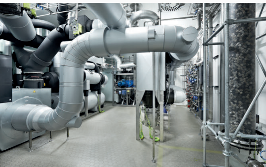
Technikbereich einer Coatinganlage mit Stickstoffkreislauf und Lösemittelkondensation
