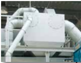
Prallkasten zur Separation grober Partikel
