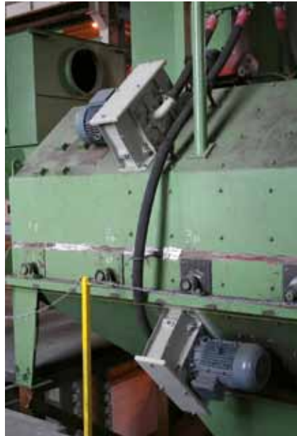
Modernisierung und Leistungssteigerung von Gebrauchsanlagen unter anderem mit moderner Turbinentechnik
