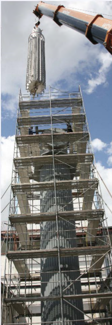
CP-Trockner bei der Montage
