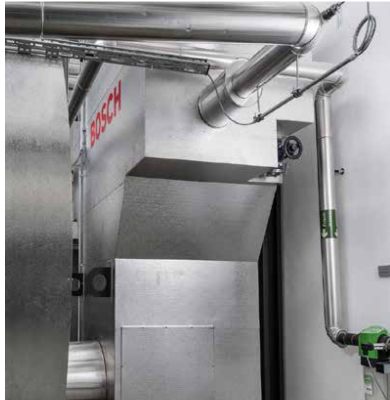
Abwärme sinnvoll zur Speisewasservorwärmung nutzen und Brennstoff sparen.
