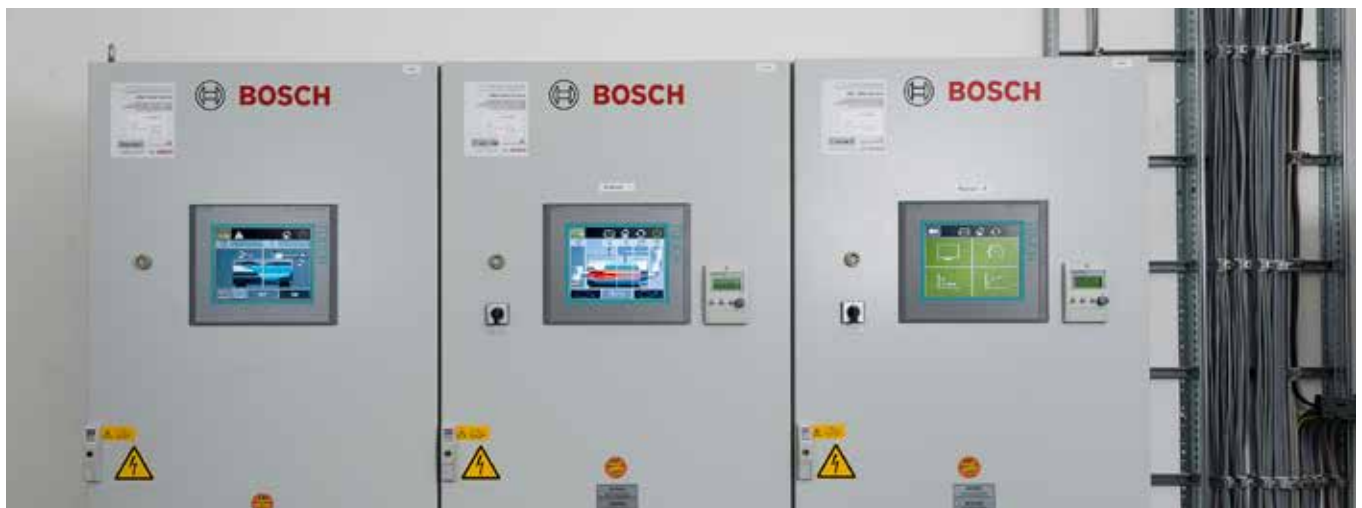
Hohe Transparenz und eine einfache Kesselbedienung gewährleisten die Kesselsteuerungen BCO mit vorausschauender Zustandsüberwachung.
