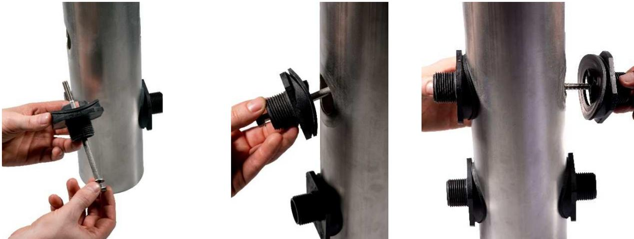
Eine Schraube M8 mit Unterlegscheibe wird durch das Außengewinde eines Gewindenippels gesteckt. Dieses Ensemble wird mit einer Flachdichtung 70x40x3 bestückt und in das seitliche Loch der Verrohrung gesteckt. Das Ende der Schraube ragt dann aus dem gegenüberliegenden Loch heraus. Hierauf werden wiederum eine Dichtung 70x40x3 und ein Gewindenippel gesteckt.
