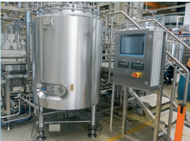
Die Installation des Wägemoduls gestaltete sich dank der integrierten Höhenverstellung von Novego besonders einfach.
