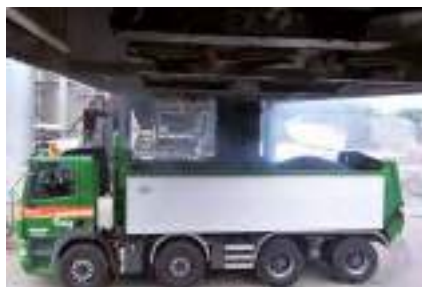
Centrale béton / asphalte
