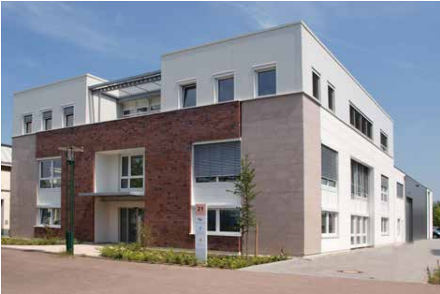
Firmensitz im Stahlwerk Becker in Willich
