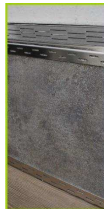
Alu Platten Halteprofil mit eingelegtem 42er Drainrost zur Verblendung der Schraub-Leiste
