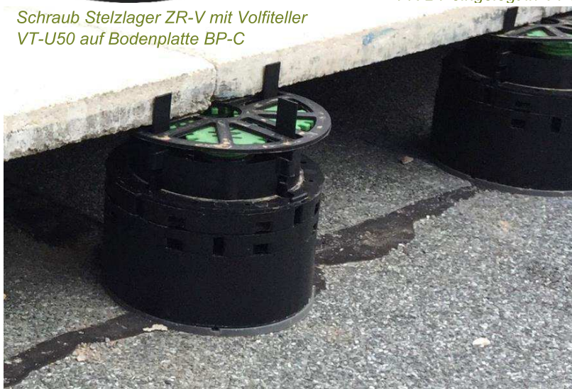
Anwendungsbeispiel VT-U50 und VT-B verlegt mit ZR-V, VT-A1.0 und VP-GKU
