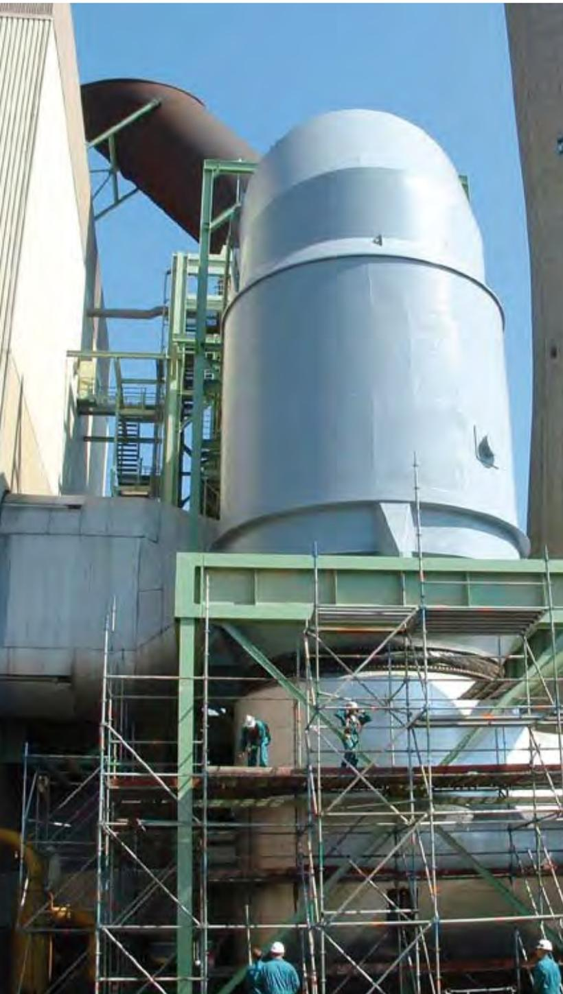
Einbau eines KOREMA® Kompensators in einer Zementfabrik
